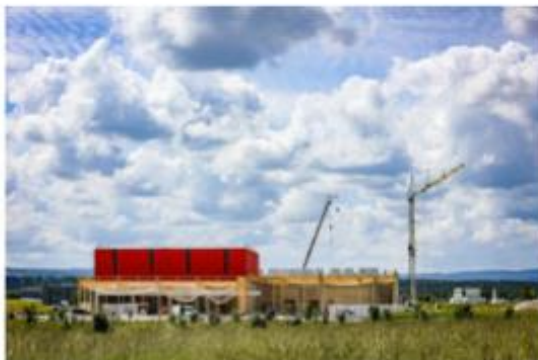
La future entreprise Gen-Hy en construction à Allenjoie, ici en juin dernier. Photo Lionel Vadani
